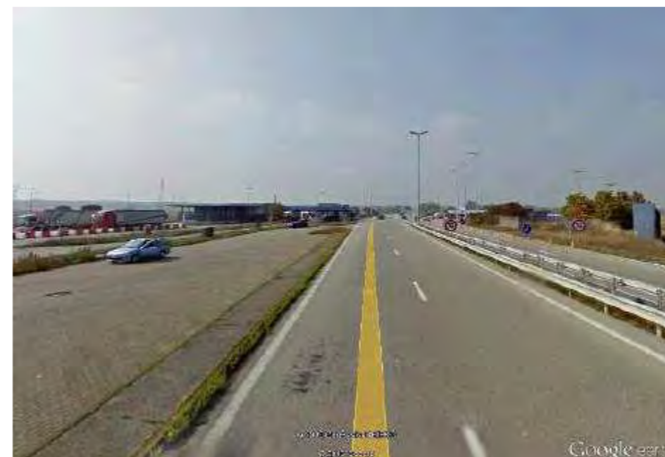
L'entrée sur le territoire français par l'A36 est dégradée, l'intégration paysagère de cet ancien poste frontière en paysage ouvert est faible.
