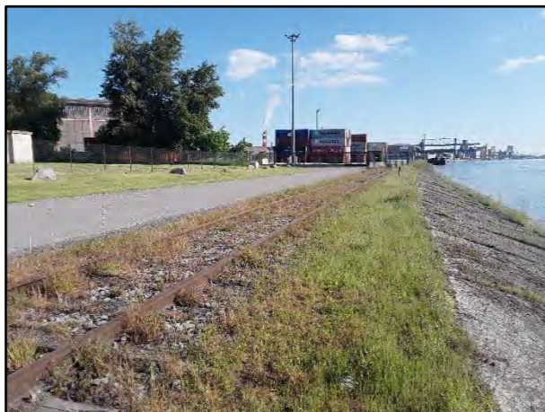
Voies ferroviaires (Rainette, 2021)
