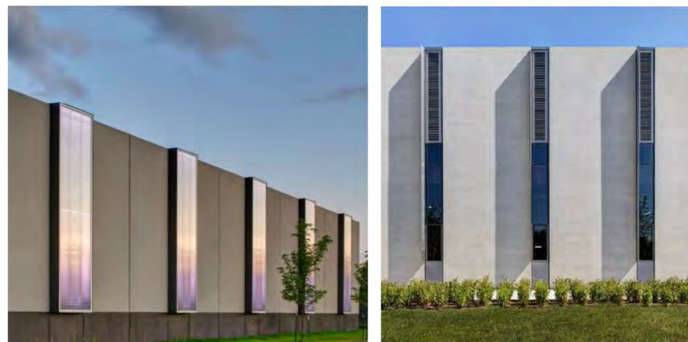
Exemples de matériaux pouvant réaliser des coupures dans la longue façade (en haut). Exemples de tentative de rythmer une façade (en bas).
